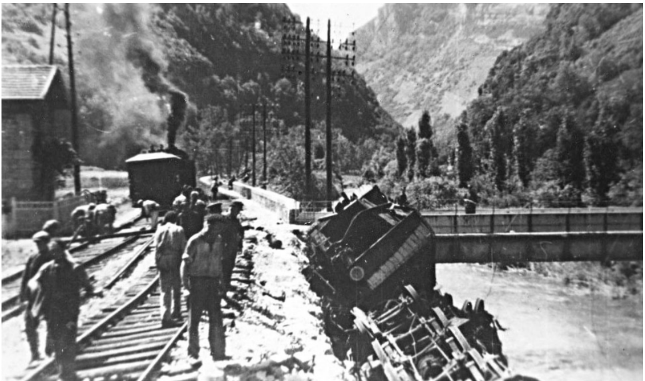
Zerstörter Bahndamm und entgleister Zug
